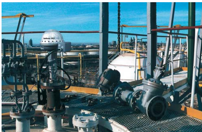
Príklad náhrady servohladinomeru radarom REX
